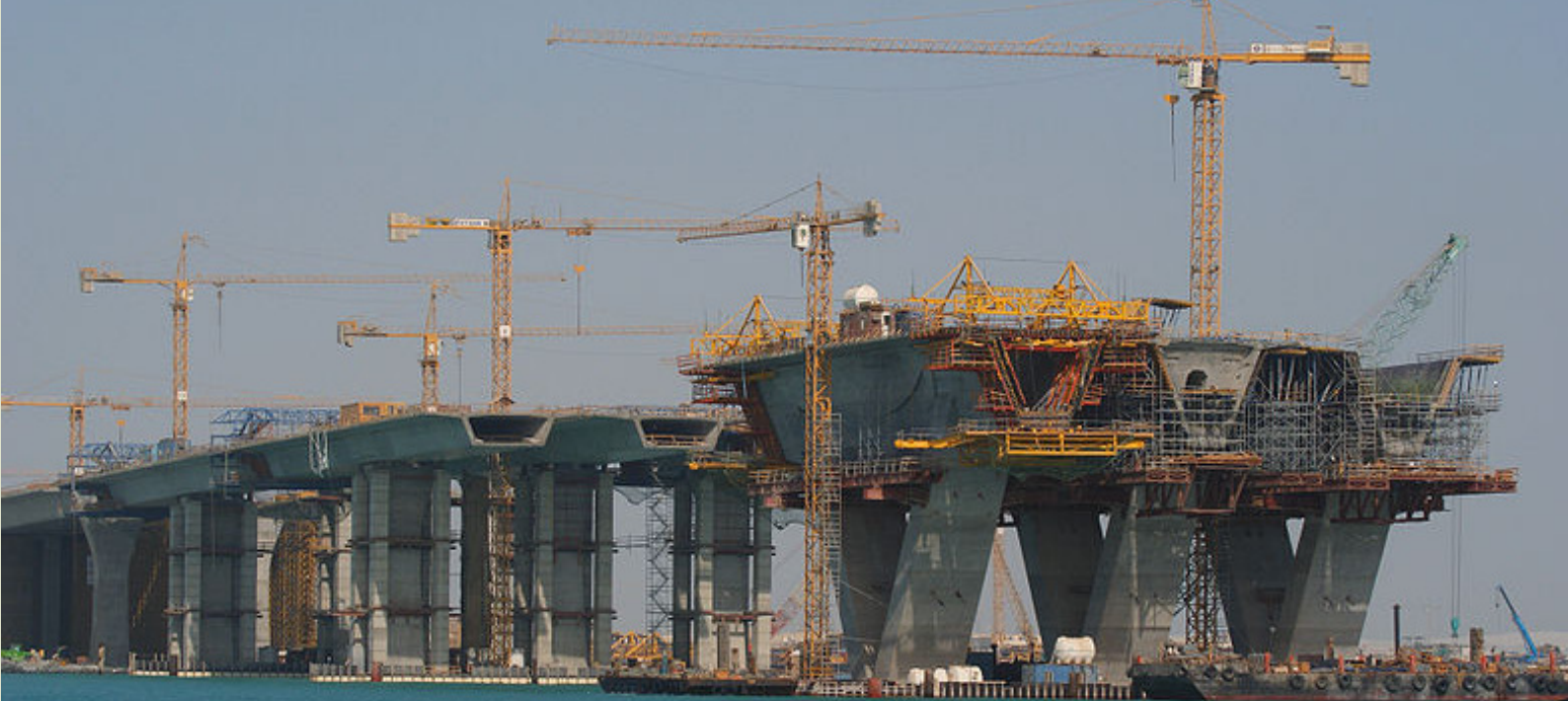
Brückenbau auf der Insel Saadiyat, Oktober 2008, Eröffnung: Oktober 2009
