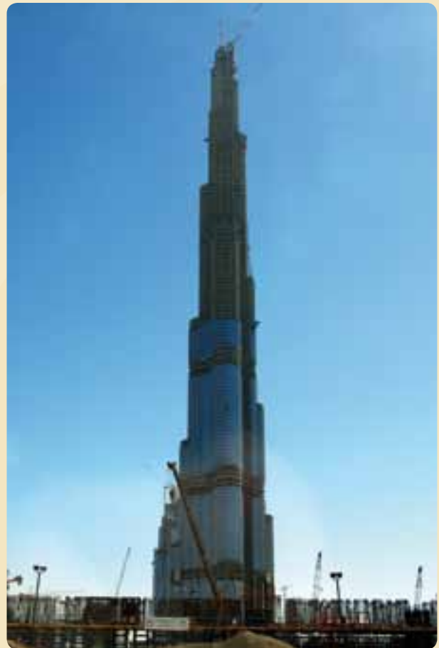
Großbaustelle Burj Dubai
